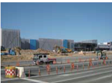
イオンモール福岡(建設中)
